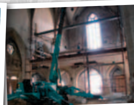
Монтаж металлоконструкций
