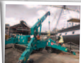
Общие грузоподъемные работы
