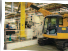
Промышленные ремонтные работы
