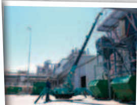
Работы по техническому обслуживанию
