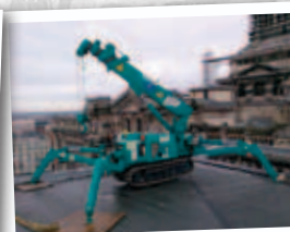
Работа на крыше
