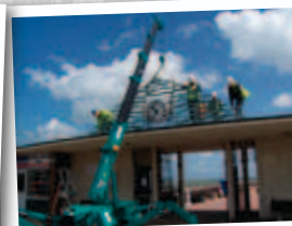
Общие грузоподъемные работы
