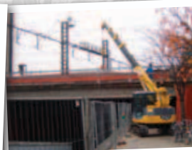
Обице грузоподъемные работы
