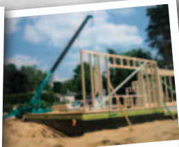
Монтаж деревянных конструкций
